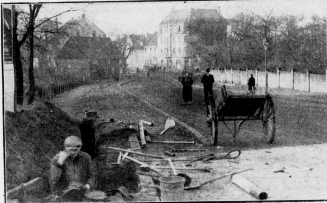
Aufnahmen: BA-Mutherr Auch der weitere Zugang zum Wiesental von Osten, von der Königsallee her, wird schön und ordentlich. — Das Bild zeigt die Wassertrasse an der Einmündung in die Königsallee, an welcher Stelle der Ausbau der Straße fast beendet ist.
