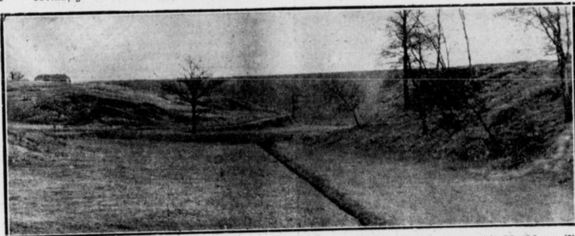
Aufnahmen: Brüggemann (1), Muthherr (2) Dieses Bild zeigt, wie tief der Einschnitt des oberen Wiefentales an der Stelle ist, an der es von dem hinten sichtbaren Damm überquert werden muß
