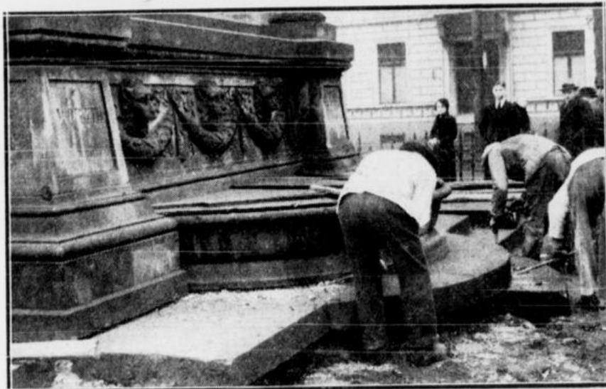
Die ersten Sockelplatten werden gelöst
