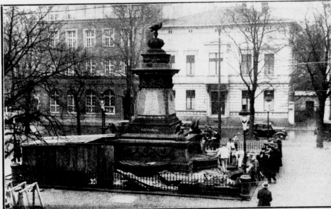
Die Abbaubarbeiten auf dem Wilhelmsplatz
