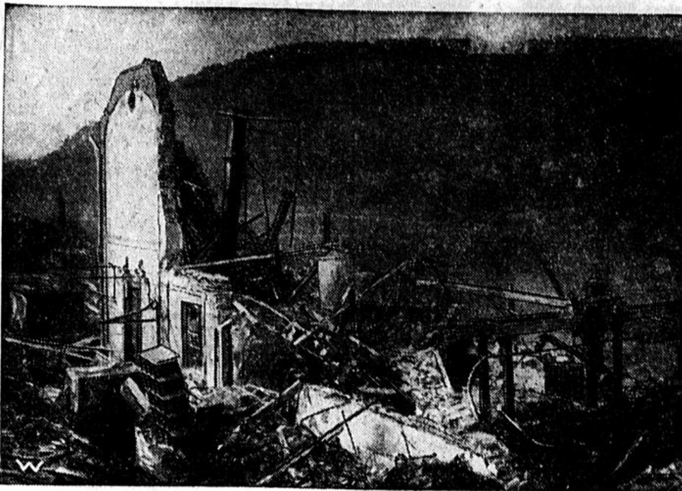
Durch die furchtbare Explosion im Kesselhause ist die Pulverfabrik Haplocher bei Wertheim in einen Trümmerhaufen verwandelt worden. Alle Anlagen sind wie nach einer Beschädigung durch Artillerie vollständig zerstört. Bisher sind 15 Tote festgestellt, verwundet sind etwa 30. Der Gesamtschaden soll eine Million Mark betragen.
