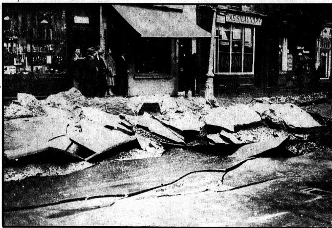
Durch unvorsichtige Handhabung eines Sauerstoffgebläses bohrte in London ein Telegraphenarbeiter eine Anzahl von Hauptgasleitungen an, wodurch infolge Explosionen über 12.000 Meter Straßenpflaster aufgerissen wurden. 400 Familien mußten ihre Wohnungen räumen. Unser Bild zeigt die High Street, wo sich die Explosion befand.
