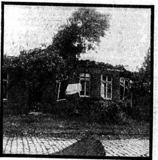
Ein Haus in einem Emsdorfe, das ein ungefähres Bild von der Katastrophe zeigt. Große alte Bäume, die wie Streichhölzer umgewandelt wurden und deren Wurzeln die Fundamente des Hauses in die Höhe hoben.
