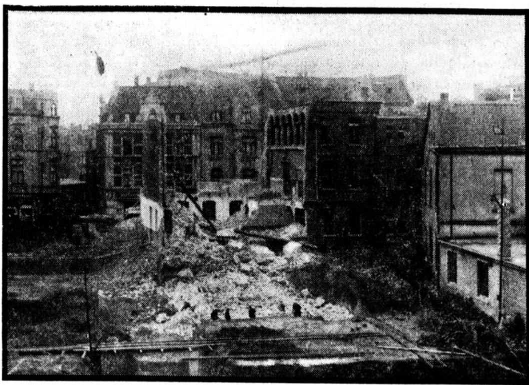
Nun ist der letzte Rest des Baues, in dem Jahrzehnte die Stadtväter und (seit 1909) Stadtmütter rateten und taten, abgebrochen. Jetzt ist das Gelände frei, um mit den Fundamentierungsarbeiten beginnen zu können. Die erforderlichen Materialien sind bereits angefahren.
