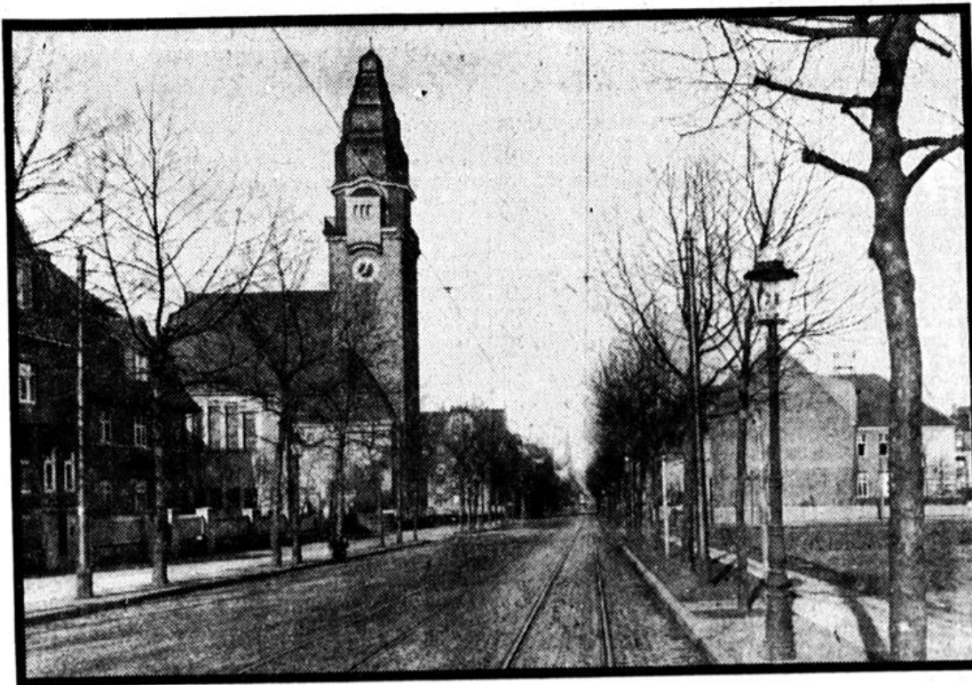
Zu den schönsten Straßen Bochums gehört die Königsallee, der erste Teil der künftigen Ruhrallee. Hier bietet sich ein städtebauliches Bild von reizvoller Wirkung. Im Vordergrund steht die Melanchthonskirche, ganz aus gewachsenem Stein erbaut, deren charakteristischer Turm sich harmonisch zu den beiden Türmen der Ruhrknappschicht fügt.
