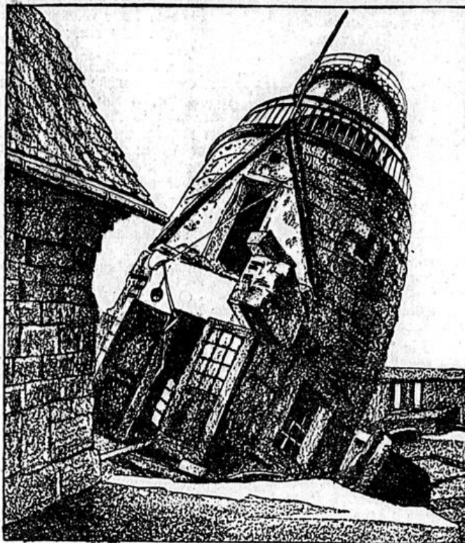
Der Leuchtturm im Bremer Hafen stark beschädigt.
