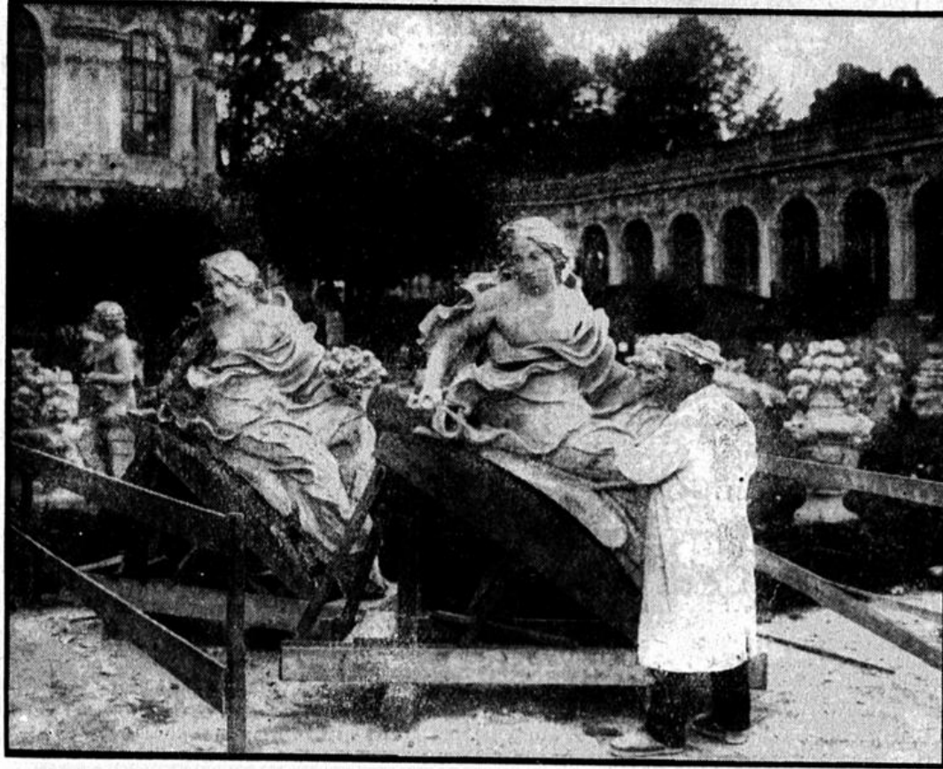
Am Dresdner Zwinger werden erhebliche Erneuerungsarbeiten vorgenommen. Unser Bild zeigt die Stuckaturen bei der Arbeit. (Atlantic-Photo.)
