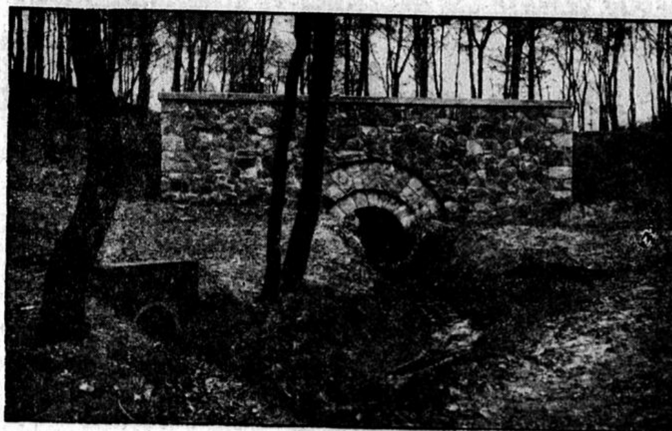
I. Ueberführung der Leitung von Schacht 10/11 der Zeche „Constantin“ über einen feilischen Zufluß zum Mühlenbach.
