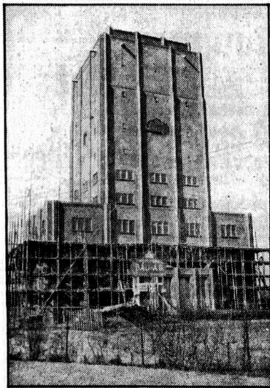
Entstehen. Der Turm oberhalb des Rathauses ist 27 Meter hoch und besitzt ein 1000 Kubikmeter fassendes Wasserbassin, worunter sich die Wohnungen befinden. Das ganze Gebäude hat eine Höhe von 40 Metern und ist 28 Meter breit. (Atlantic-Photo.)
