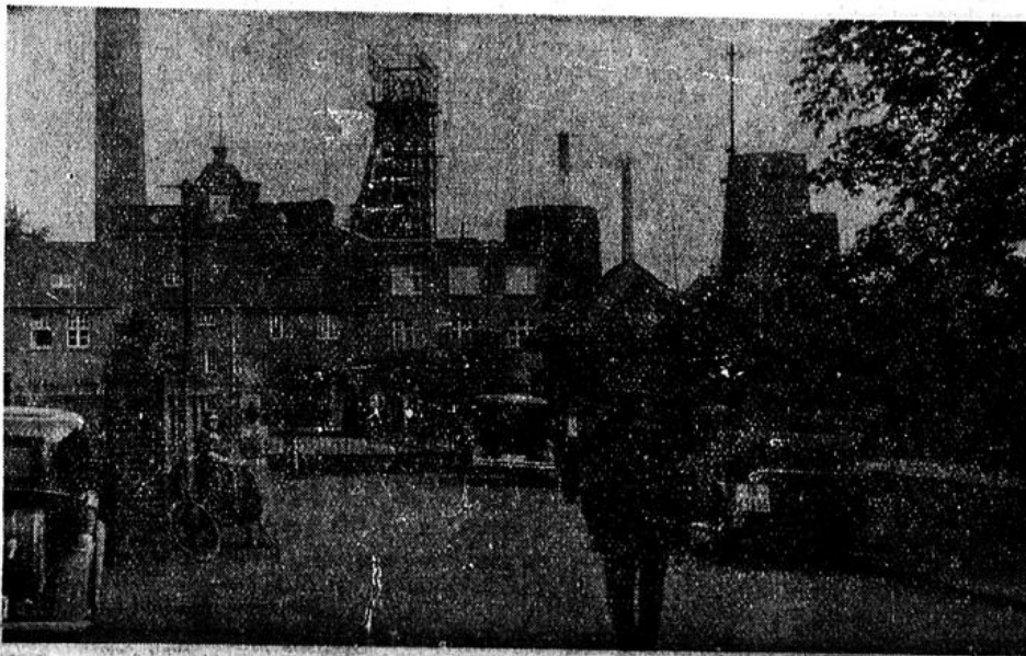
Das Portal der Zeche Adolf von Hansemann mit dem Unglückschacht im Hintergrund.
