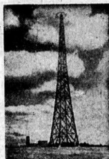
Einer der beiden gesprengten Sendetürme
