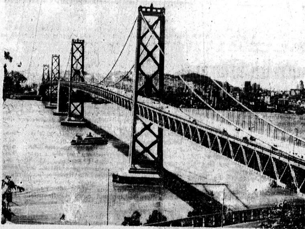
Die weltberühmte Brücke von San Franzisko, Schauplatz der gegenwärtigen Konferenz.
