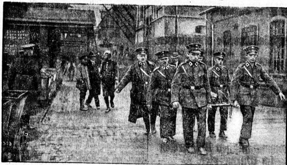
Sanitäter bei den Rettungsarbeiten auf der Grube Maybach.
