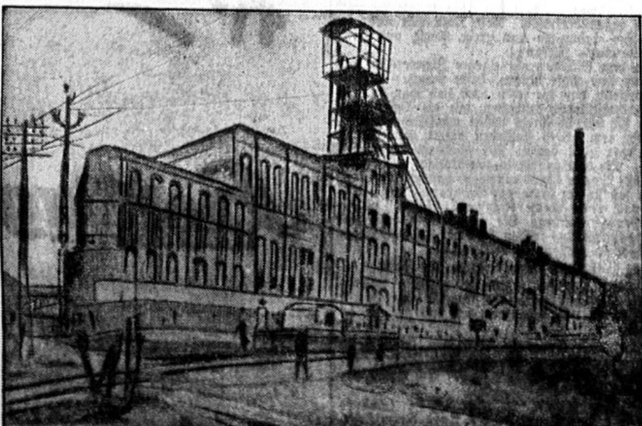
Der Förderturm des Wilhelm-Schachtes der Grube „Anna“, der bei dem Unglück eingestürzt ist.
