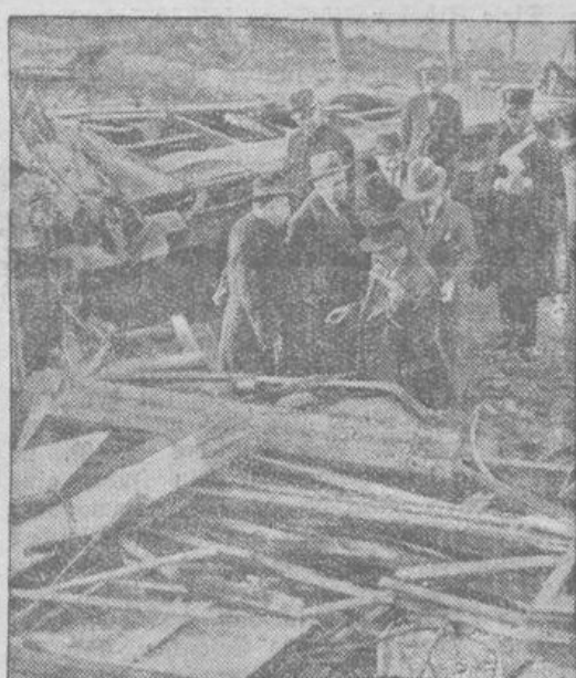
Der Absturz der Drahtseilbahn auf dem Vesuv. Beim Zusammenstoß mit einem Pfeiler ist der Führerwagen der Drahtseilbahn auf den Vesuv abgestürzt. Sieben Personen kamen dabei ums Leben, während neun schwer verletzt wurden. Das Bild zeigt die Trümmer des abgestürzten Wagens am Fuße des Vesuvs.
