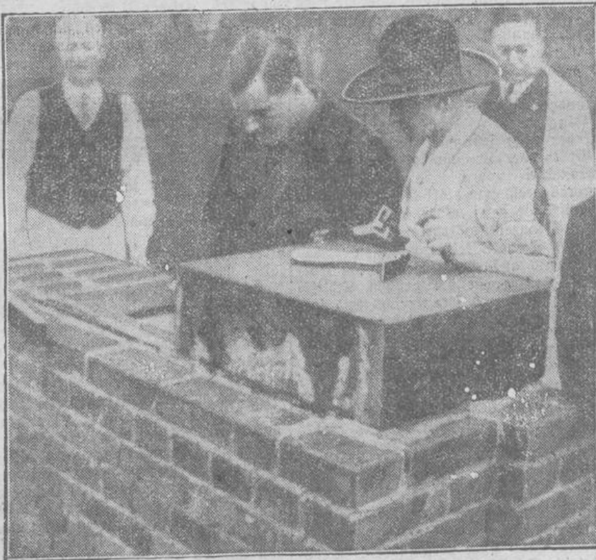
Balduur v. Schirach legte den Grundstein zur „Paul-von-Hindenburg“-Jugendherberge. Mit großer Feierlichkeit wurde am Masch-See in Hannover der Grundstein zur Jugendherberge der Stadt Hannover gelegt, die den Namen „Paul-von-Hindenburg“-Jugendherberge erhalten wird. Man sieht auf dem Bild Balduur v. Schirach beim Verlegen der Grundsteinlegungsurkunde in den Grundstein.
