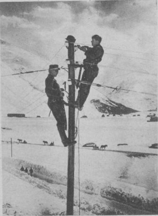
Beim Anlegen einer Telegraphenleitung.
