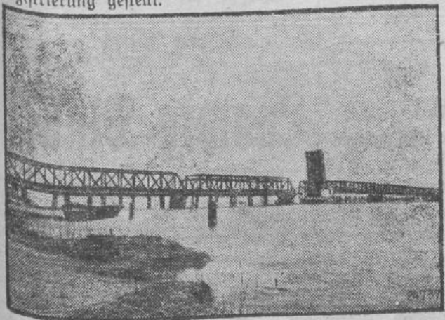
Die Usedomer Bäderbrücke fertig.
