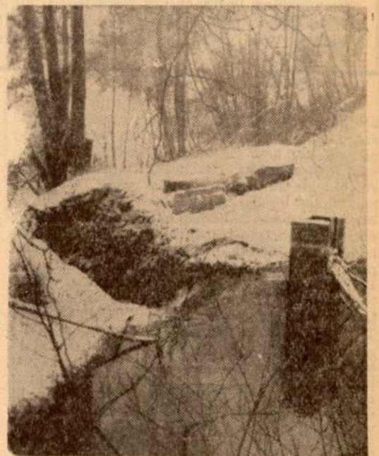
Die Durchbruchstelle im Damm des Oedenthaler Teiches.
