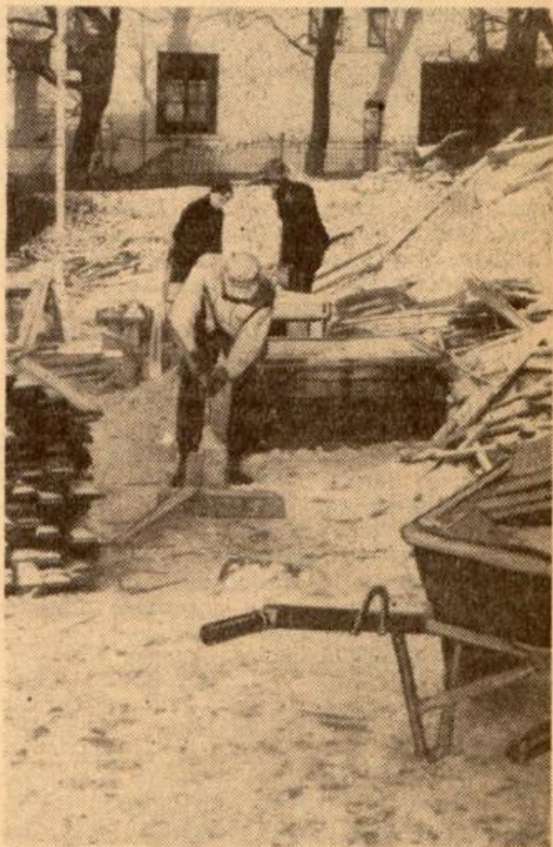
Holzhacken und Feuern — eine wichtige Aufgabe für die noch beschäftigten Bauarbeiter. Man muß für Wärme sorgen, damit die eben erst gesetzten Innenwände und die Hände nicht dem Frost erliegen. Aufn.: Schulte
