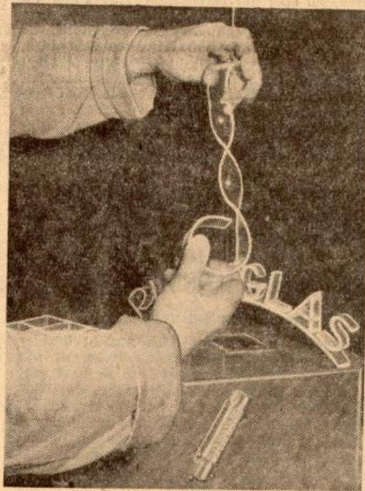
Auf eine bestimmte Temperatur gebracht, läßt sich Plexiglas biegen und verdrehen, wie es der Kunde wünscht. Foto: Schulte
