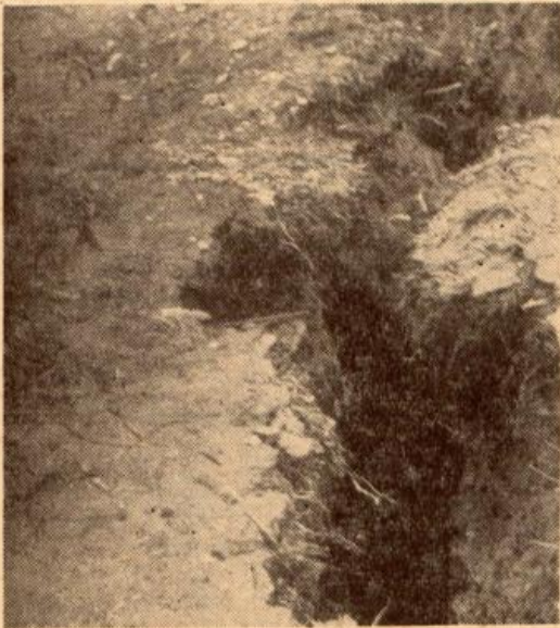
Dieser Riß im Erdreich der Tunnelböschung, der sich von Montag auf Dienstag bildete, ist einen halben Meter breit und fast zwei Meter tief. Langsam aber sicher drücken die Erdmassen in Richtung Gieße, so daß eine sofortige Gegenmaßnahme notwendig wurde. (Foto: Schulte)
