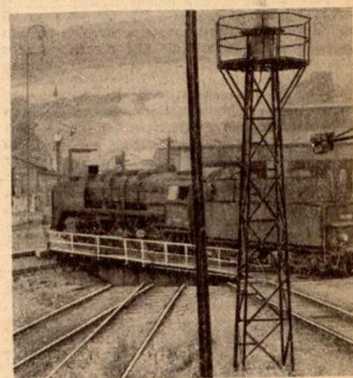
Eine große Lokomotive auf der Drehscheibe. In Brügge werden täglich etwa 130 Güter- und Reisezüge abgefertigt, die zum größten Teil aufgelöst und neu gebildet werden müssen. Die vier Strecken, die hier zusammenlaufen, halten die Drehscheibe fast ständig in Betrieb. Fotos: Breilbach
