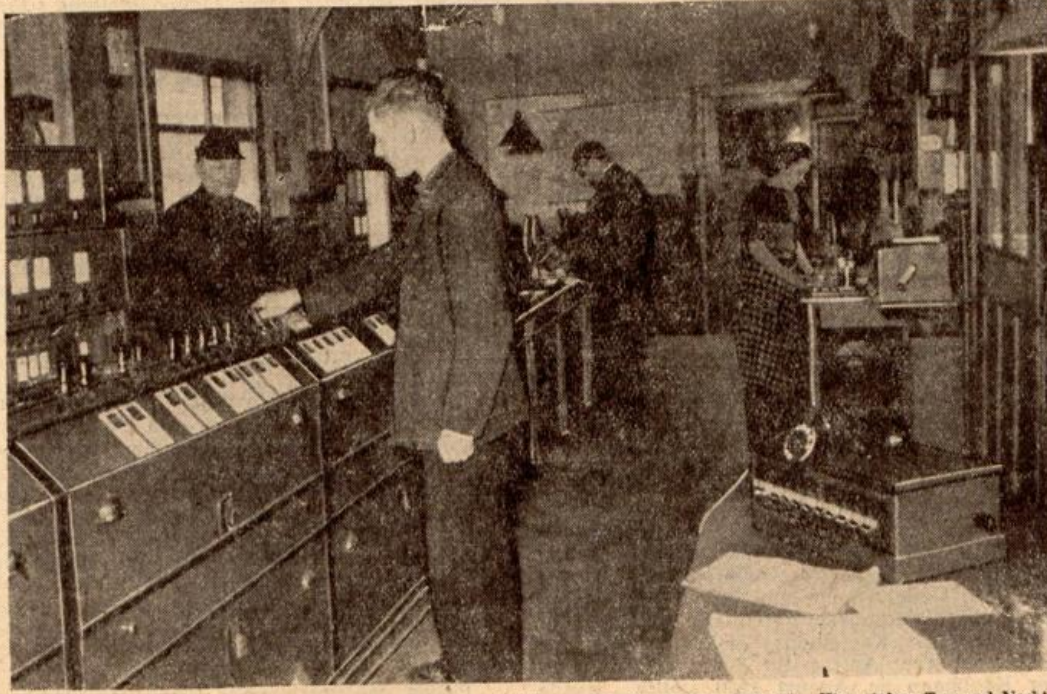
Ein Blick in das Innere des Hauptstellwerkes BÜ (eine Abkürzung des Ortsnamens Brügge). Hier stehen Tag und Nacht die Beamten an ihrem Platz, um, wie die Dame rechts und der Herr im Hintergrund, die Befehle des Fahrdienstleiters weiterzugeben, Meldungen entgegenzunehmen oder die elektrischen Stellwerkeinrichtungen zu bedienen.
