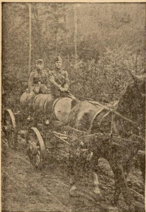
Mittlings auf dem Wassertank Wasser für die Betonmischung wird geholt. M.-H.-Weltbild (M).
