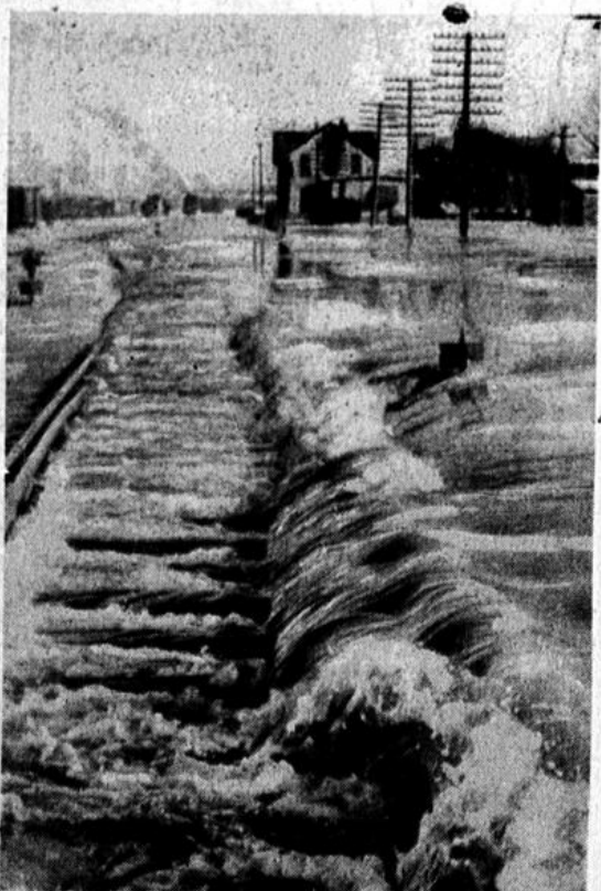
Die Flutwelle kommt! Die Gleisanlage des Bahnhofs Kairo im Staate Illinois im amerikanischen Überflutungsgebiet ist gleichsam zu einer Wehr geworden, über das unablässig an einer Mauer in die tiefer gelegenen Randstriche strömen. (Associated Press, A.)
