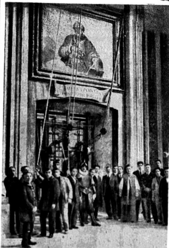
Der Mechanismus zur Öffnung der Heiligen Tür in der Peterskirche in Rom, mit welchem feierlichen Akt das Heilige Jahr auch diesmal eingeleitet wurde. Eine Anzahl von Arbeitern steht unter der Leitung eines Geistlichen bereit, um die Tür zu lenken, sobald der Papst auf der anderen Seite mit dem Hammer dreimal angeschlagen hat. Die Tür wird dann auf den am Gestell befestigten Rädern fortgeschoben und der Papst tritt nunmehr als Erster durch die Türöffnung.
