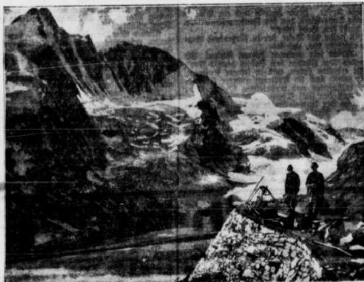
Auf dem Großlodner wird jetzt ein bequemer Promenadenweg gebaut, der bereits große Fortschritte gemacht hat. Man sieht hier einen Blick auf den Bau des Promenadenweges zum Wasserfallwinkel. Im Hintergrund der Großlodner und der Pastergrasfelder. (Atlantik-Bl)
