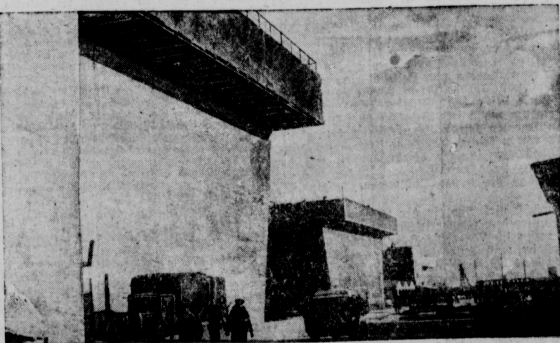
Bunkerstadt am Atlantik
