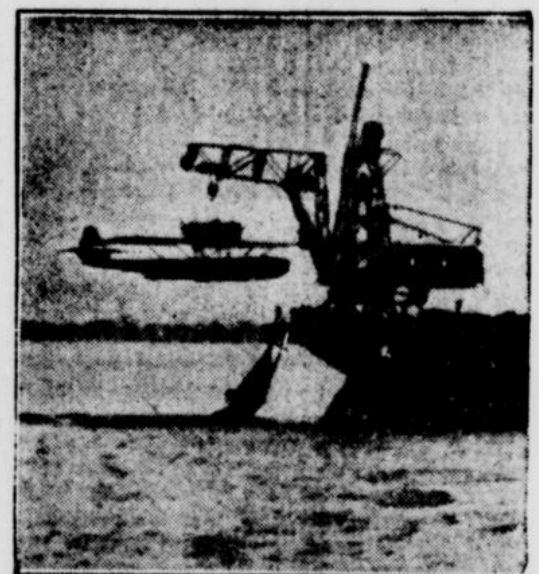
Probefahrt des Katapultschiffs Westfalen Das Heck der „Westfalen“ mit geflutetem Schleppsegl, von dem nur die beiden Enden zu sehen sind; der 90 Tonnen schwere Kran ist ausgehwenkt und hat den Porrier-Wal aus dem Wasser gehoben
