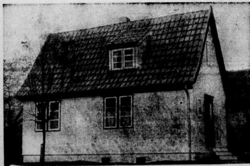
So steht der Bauring-Haustyp mit vier Räumen aus
