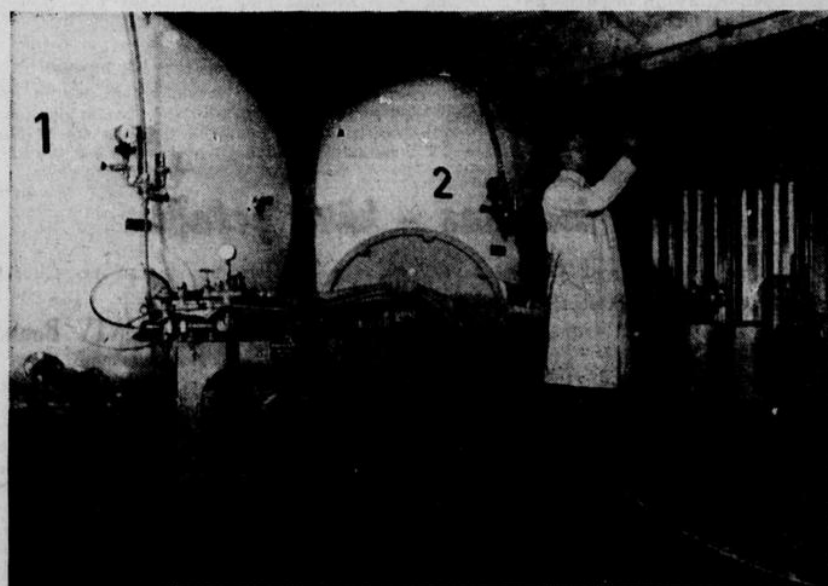
Filtrationsanlage in einer modernen Apfelsaftkellerei
