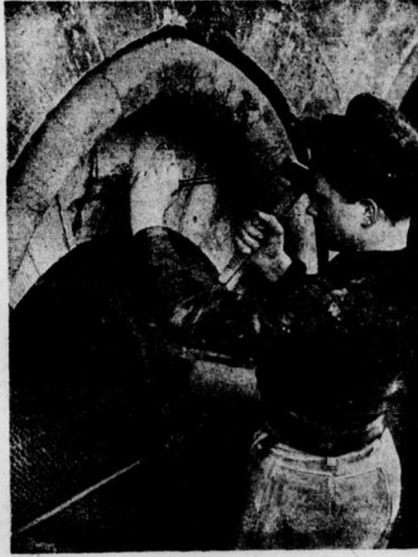
Die beschädigten Teile des Kapitells müssen erneuert werden — Aus einem Spitzbogen wird ein geborstener Stein entfernt
