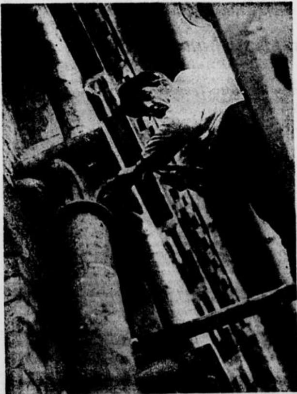
Die beschädigten Teile des Kapitells müssen erneuert werden — Aus einem Spitzbogen wird ein geborstener Stein entfernt
