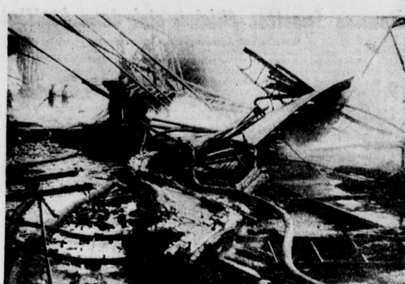
Durch Explosion mehrerer Sauerstoff-Flaschen entstand dieser Tage in der Fettraffinerie Brake bei Bremen ein Großbrand, zu dessen Bekämpfung die Feuerwehren aus Bremen, Oldenburg, Brake und zwei amerikanische Feuerlöschboote aus Bremerhaven eingesetzt werden mußten. Vernichtet wurden die Wasserstoff-Füllstation und ein kleines Lager. Die eigentliche Anlage der Fettraffinerie wurde durch das Feuer nicht betroffen. Immer wieder flackern Brände in den Trümmerresten auf, die von der Feuerwehr gelöscht werden.
