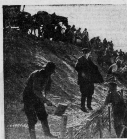
Der Strom ist in sein Bett zurückgekehrt, die Bauern gehen an die Instandsetzung und Verhärtung des Deiches
