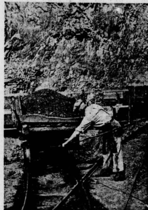
Rippwagen schaffen das Gestein zum Steinbrecher. Mit einer Winde werden die Wagen von der Talsohle auf den höher gelegenen Schienenweg gezogen.
