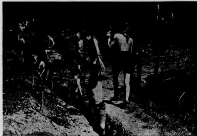
Die tüchtigen Landjahrjugenden helfen beim Bau einer Wasserleitung. Mit frischem Mut sind sie am Werk und eifrig wird die Kreuzbaue geschwungen und der Graben mit dem Spaten ausgehoben.
