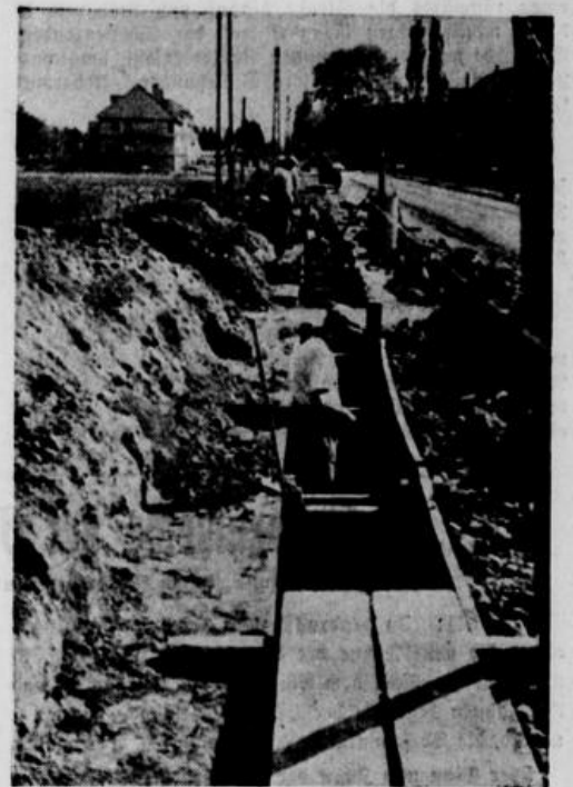
Recht In der verlängerten Heerstraße wird „gebuddelt“: die Kanalisation wird angelegt.
