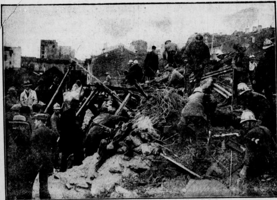
Beim Hauseinsturz in Vincennes in Frankreich sind bis jetzt 19 Verunglückte geborgen. Da die Aufräumarbeiten trotz des großen Aufgebots an Militär und Feuerwehr sich sehr schwer gestalten, konnte die genaue Zahl der Opfer noch nicht festgestellt werden.
