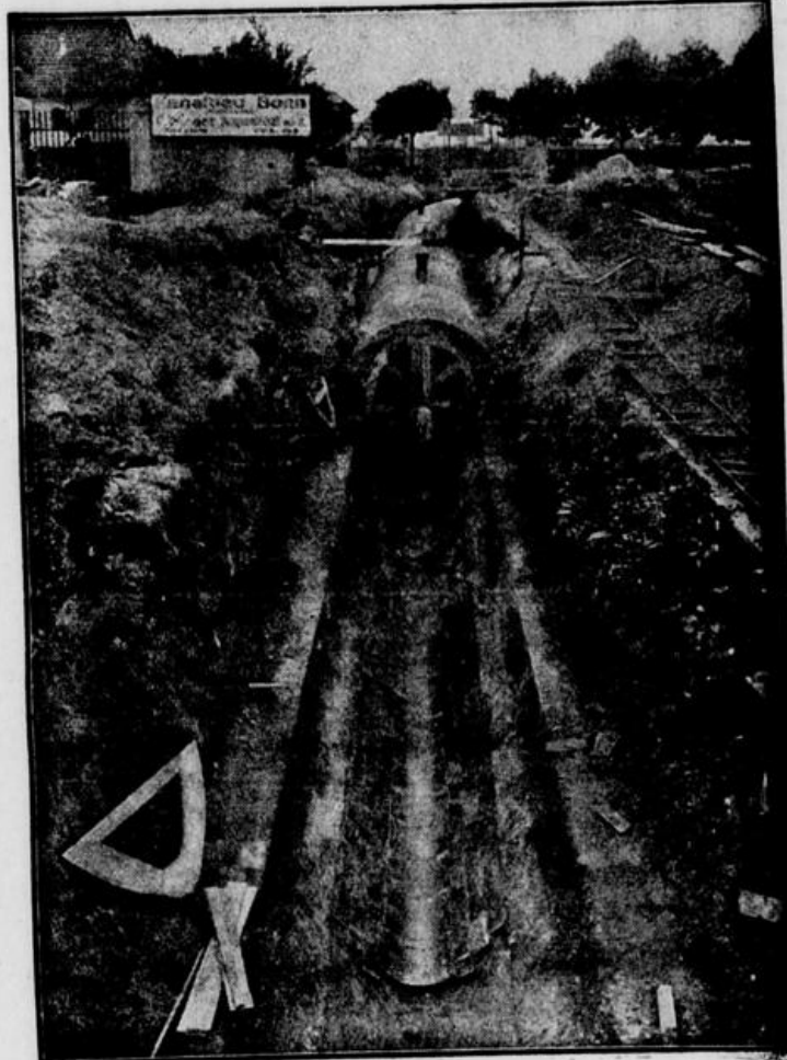
Beginn der Kanalfaktion. Zu achten ist auf die glasierte Steingewölbe in der Kanalschale, die zum Schutz des Betons dient.
