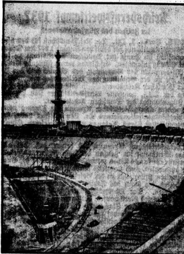
Blick auf die fast fertiggestellte Nordturm der Mäus, der schnellsten europäischen Autobahn. Im Hintergrund das Meeresgelände mit dem Funkturm.
