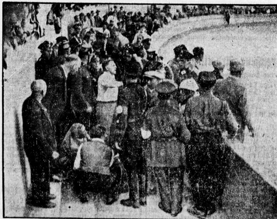
Blick auf die Unglücksstelle kurz nach der Katastrophe.
