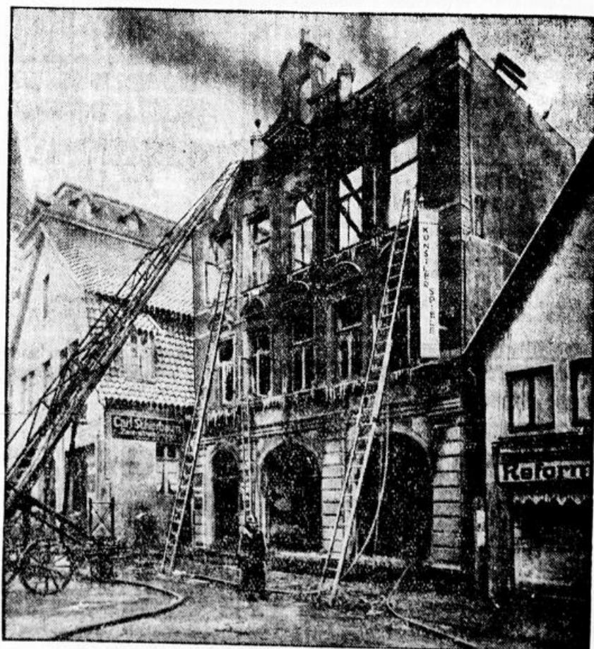
Das völlig zerstörte Hotel „Zur Traube“ in Detmold.
