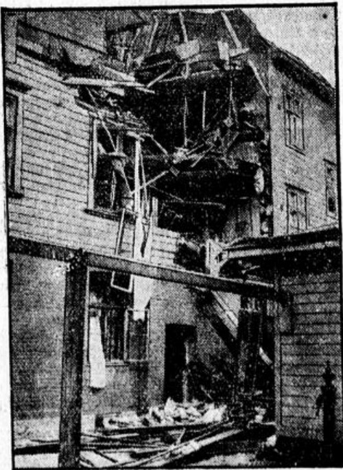
Das zerstörte Haus.
