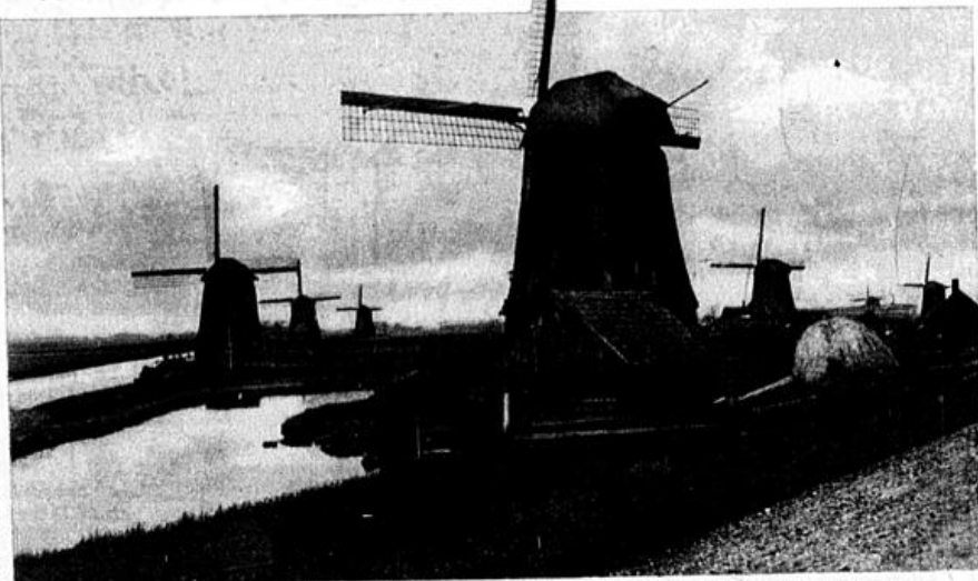
Windmühlen in Nordholland. Sie heben mittels archimedischer Schrauben das Wasser aus den Voldern in die Kanäle
