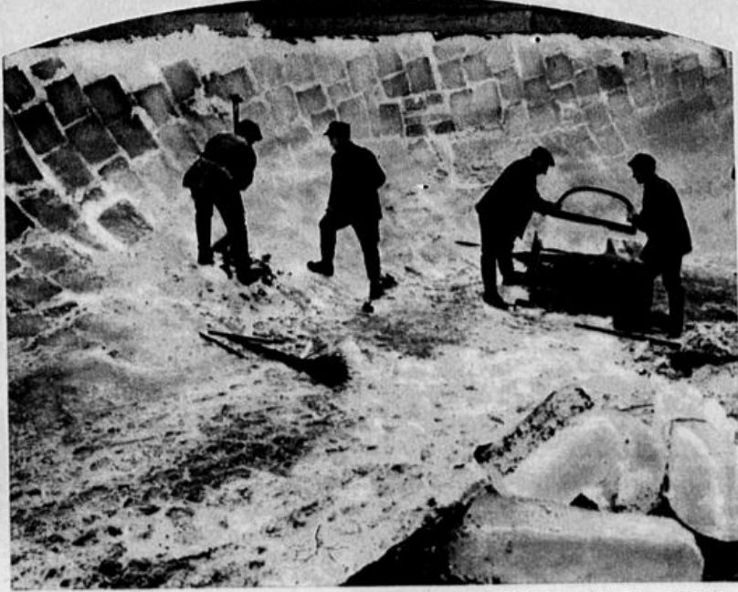
Wie eine bei Tauwetter aufgeweichte Bobbahn für die Meister- schaftsrennen neu wiederhergerichtet wird. Der Untergrund wird aus säuberlich zurechtgefägten Eisblöcken gebaut. Darüber kommt die Schneebahn Photothef
