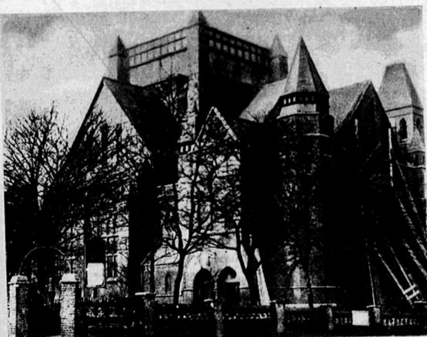
Eine Kirche in London, aus deren Boden plötzlich ein starker Wasserstrahl herausdrang. Es stellte sich heraus, daß der Untergrund durch einen unterirdischen Wasserlauf unterhöhlt ist. Die Kirche muß daher niedergelegt werden Welt-Photo
