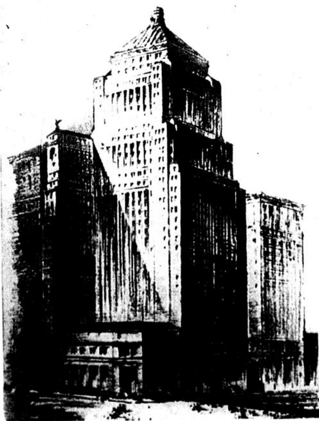
In Newyork ist ein neuer 34 Stockwerke hoher Wolkenkratzer für die Morgan-Bank errichtet worden
