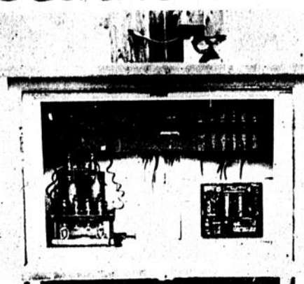
Ein Relaisstation; links ein Gleisrelais, rechts ein Weichenrelais
