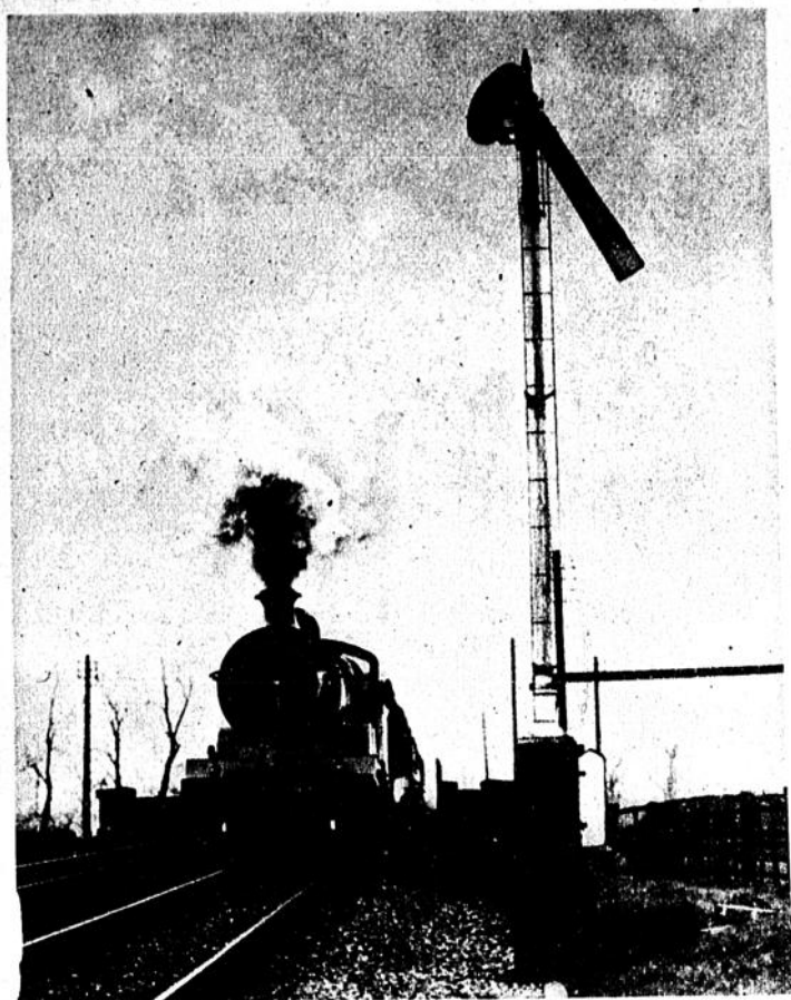
Automatische Zugsignalisierung; der Signalarm zeigt „Gefahr“ an (Text siehe rechts)
