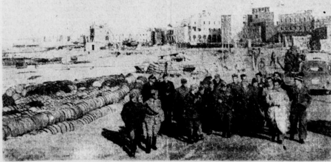
Die ersten Aufnahmen aus dem wiedereroberten Bengasi. Dieses Bild aus der wichtigen Hafenstadt Bengasi in der Cyrenaika, die jetzt in harten Kämpfen den Engländern wieder entrissen wurde, zeigt General Bastico mit seinem Stabe bei der Besichtigung der wiedereroberten Stadt. Links einige Häuser mit Treibstoff, von dem die Engländer riesige Mengen zurücklassen mußten. Luce-Press-Hoffmann
